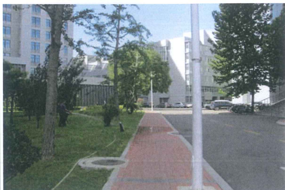
透水砖铺装及绿化
