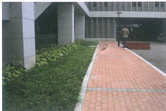
透水砖铺装及绿化
